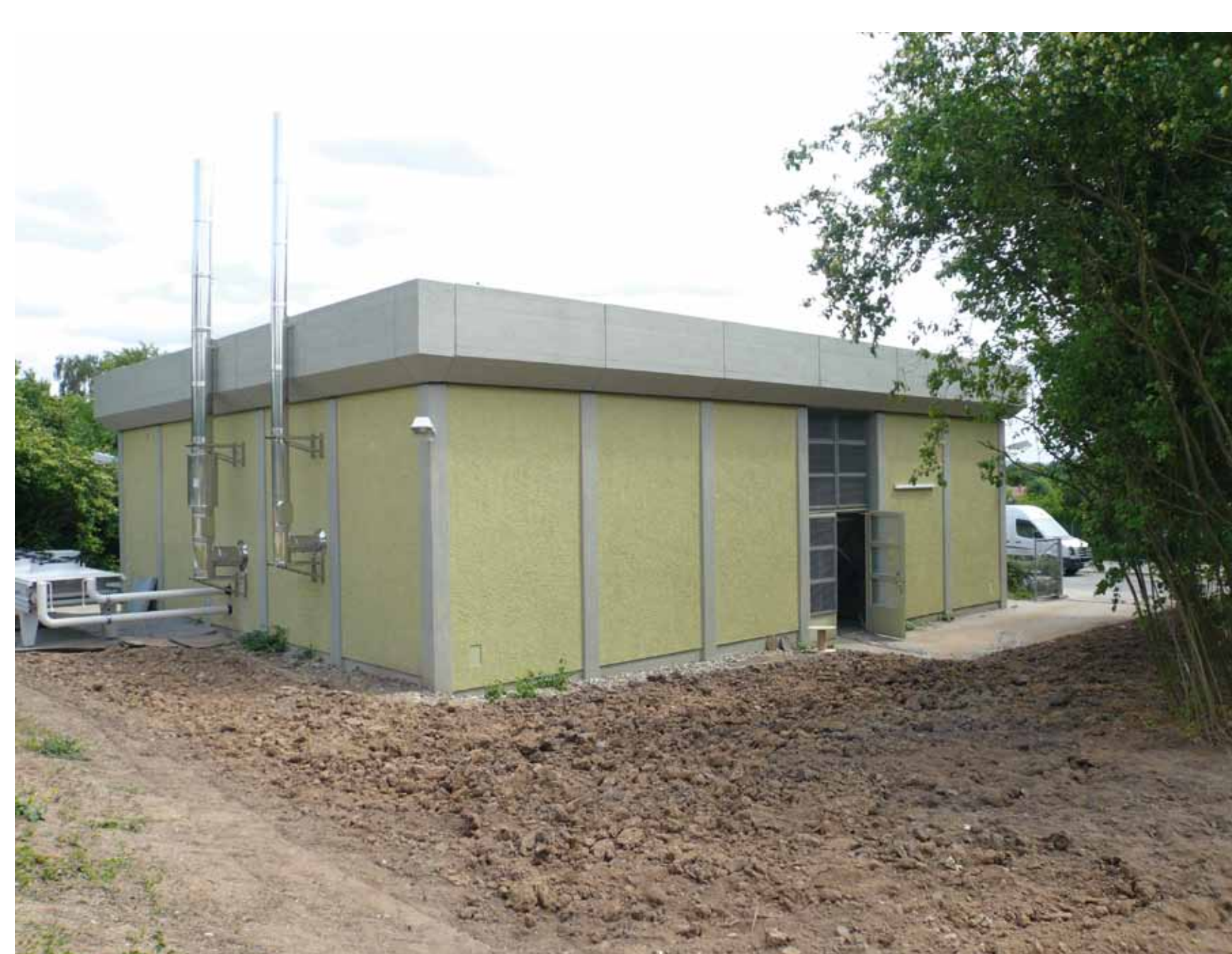
Verlegung Erdsonden // Rückkühlung // Verlegung Rehau // Heizzentrale
