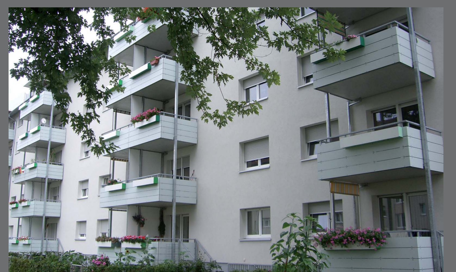
Gebäude nach der Sanierung
