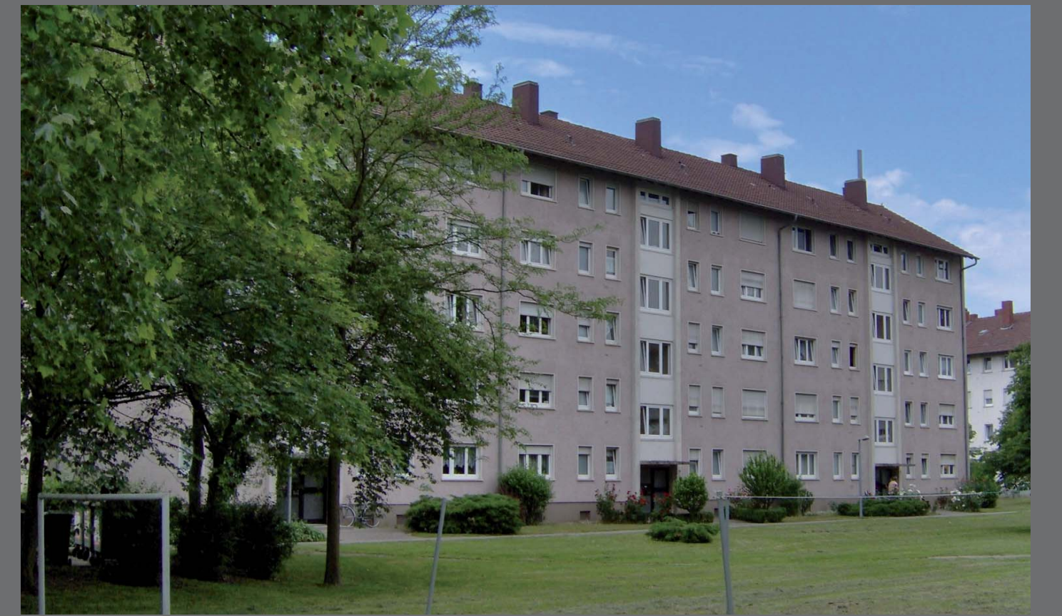
Gebäude vor der Sanierung
