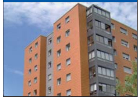
Abb. 5: Eines der Wohnhochhäuser nach der Sanierung
