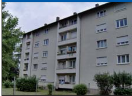
Abb. 4: Typisches Riegelgebäude im Ausgangszustand
