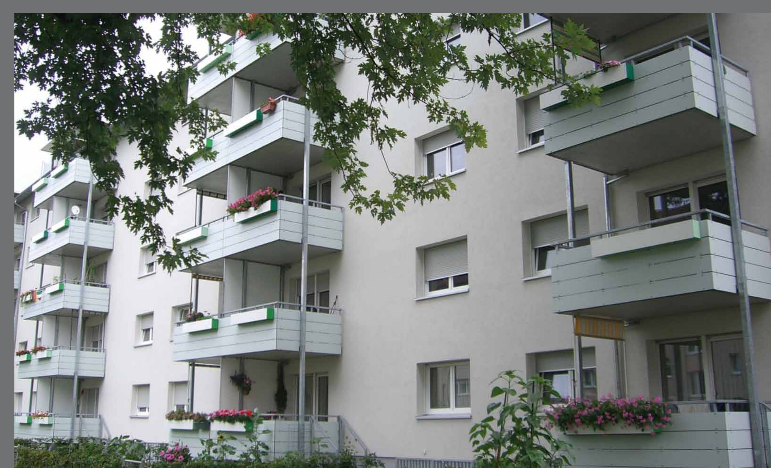
Gebäude nach der Sanierung
