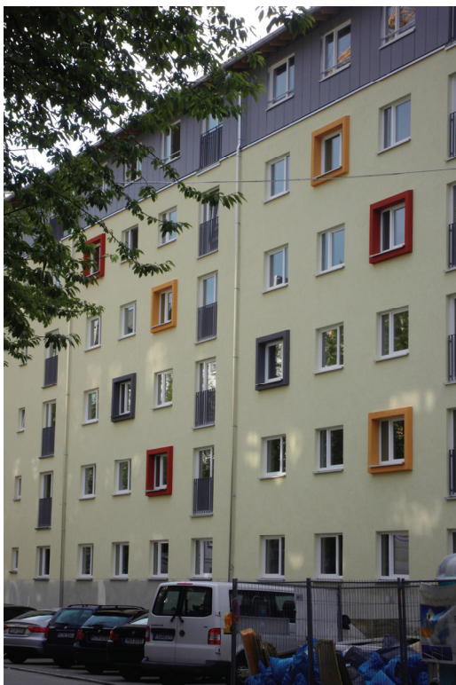
Bild 1: Ansicht der mit Vakuumdämmung energetisch hochwertig sanierten Fassade des EnEff:Stadt-Demonstrationsvorhabens in der Lilienstraße.
