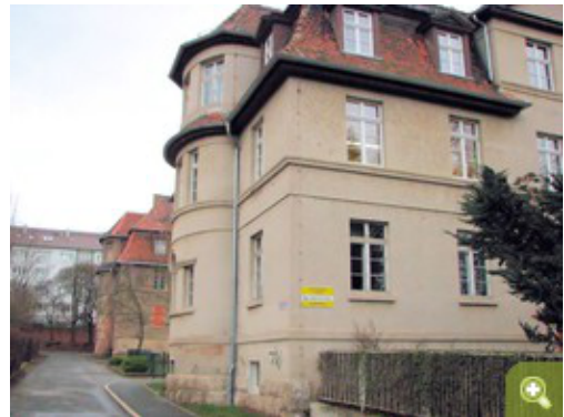
Sanierungsobjekt im innenstadtnahen alten Zöllnerviertel
