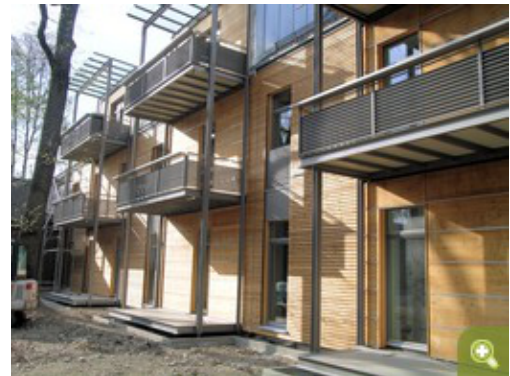
Bereits saniertes Wohngebäude mit Solaranlage und Holzfertigteil-Fassadensanierungselementen © B&O Wohnungswirtschaft, SCHANKULA-Architekten/Diplomingenieure
